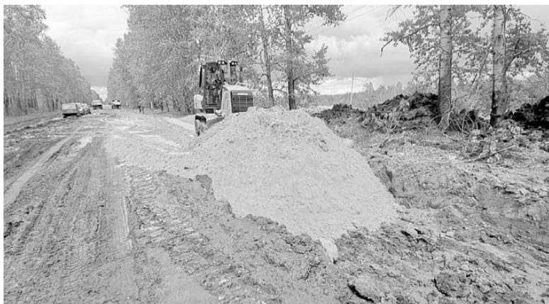
Работы на дороге Ромны-Поздеевка. Фото А.Буркова
