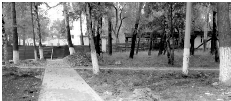
Работы по благоустройству площади с. Ромны
