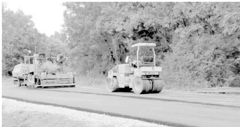
Укладка асфальта на улице Школьной с. Ромны
