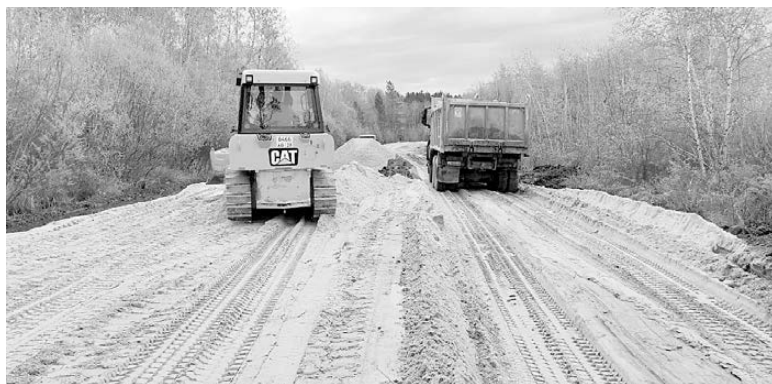
Дорожные работы в районе Каховки. Фото Алексея Буркова
